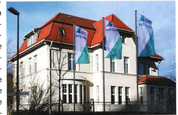
Das Verwaltungsgebäude der „BEA Batterien GmbH“ in Oberschöneweide
